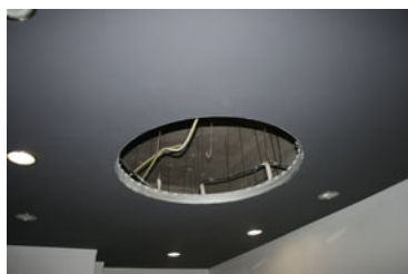
Detalles del montaje de una Caja de Luz redonda empotrada a Techo
