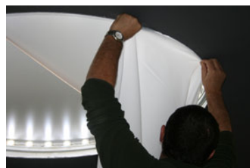
Detalles del montaje de una Caja de Luz redonda empotrada a Techo
