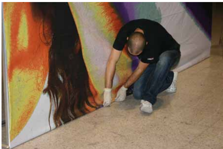
DESPUES METEMOS LA SILICONA POR LA PARTE DE ABAJO
