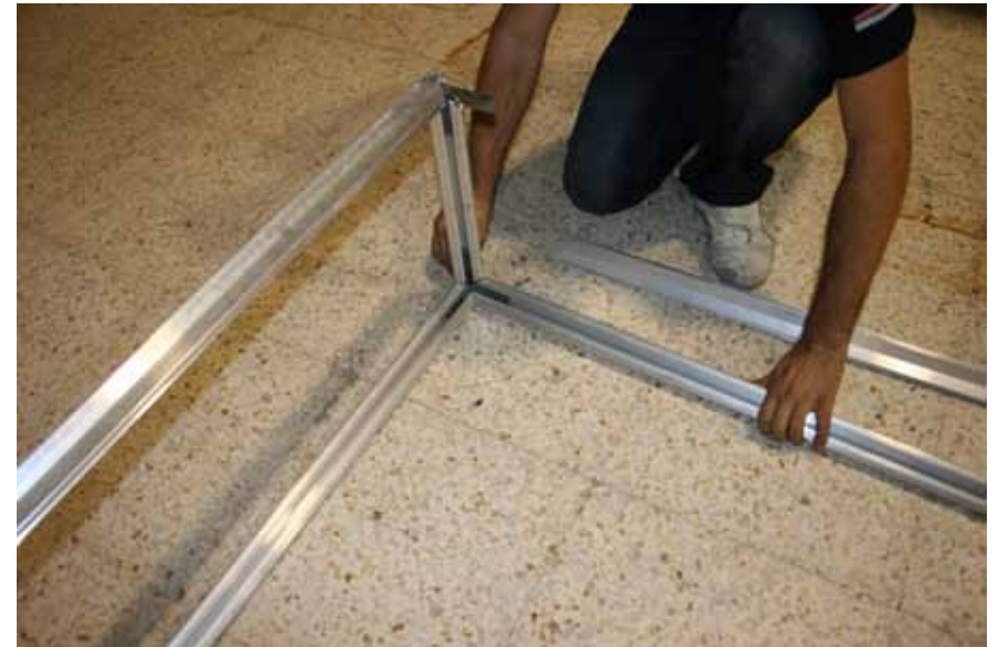
SE METEN LOS TUBOS DE LA PARTE BAJA PRIMERO
