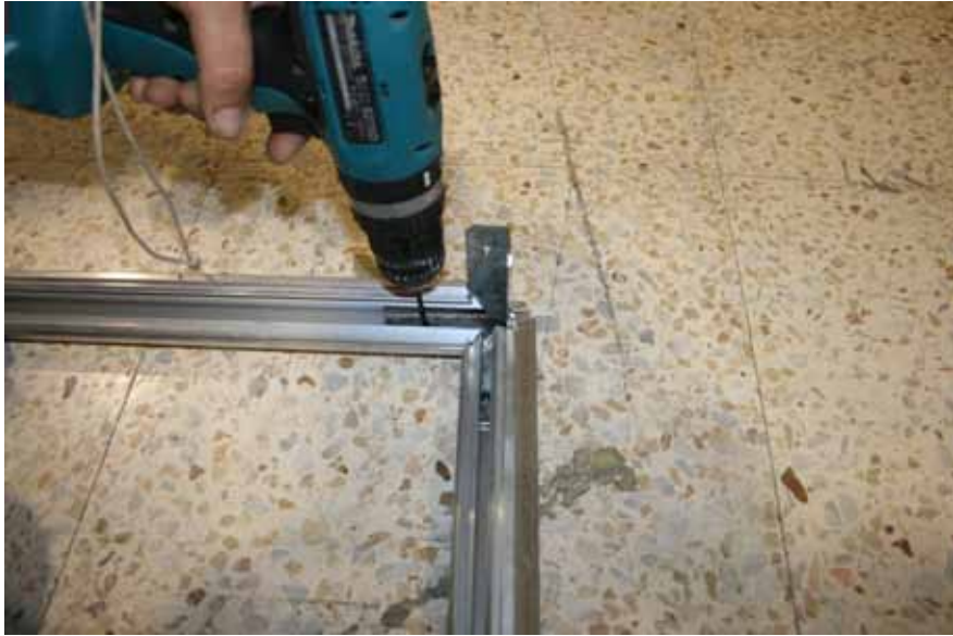
DESPUES SE APRETAN LOS TORNILLOS ALLEN
