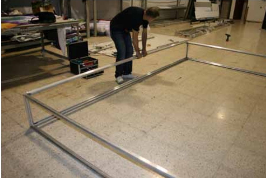
DESPUES LOS TUBOS DE LA PARTE DE ARRIBA
