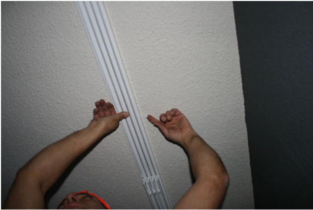
Colocar el riel girando la lengüeta
